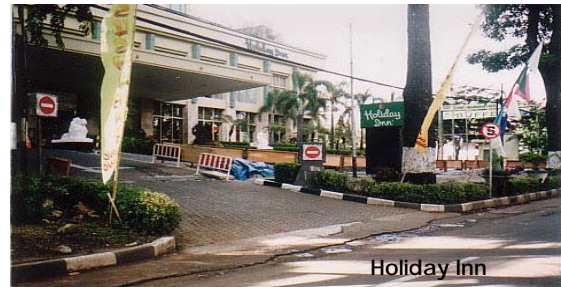
Gambar 11. Suasana pedestrian di depan 'holiday inn' Jl. Juanda Bandung yang 'merebut' trotoar untuk fungsi parkir hotel, pejalan akhirnya memilih untuk berjalan di jalan raya karena merasa lebih nyaman, tidak perlu naik turun atau melewati lubang-lubang. Sumber: Dok. Pribadi 2003
